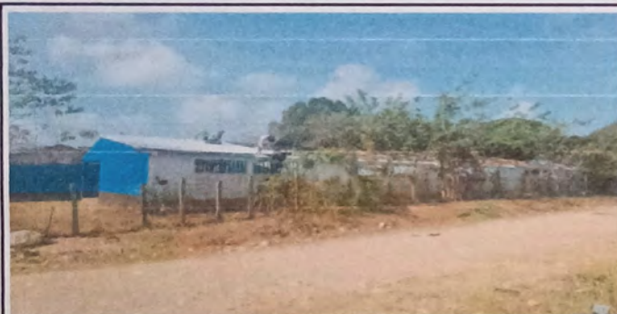
Foto 3: Entecho del Modulo 3.
