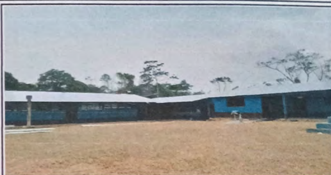
Foto 2: Entecho del Modulo3
