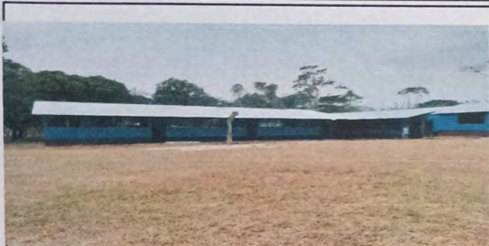
Foto 1: Entecho del Modulo1
